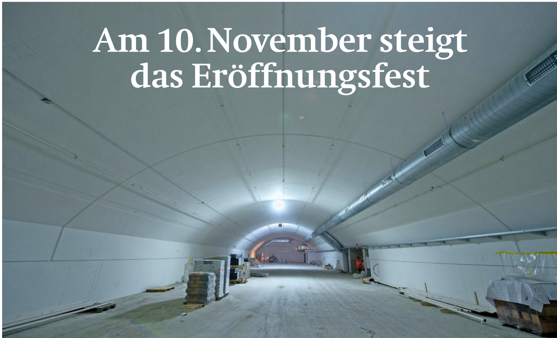
Das künftige oberste Parkdeck auf der Seite Obere Hauptgasse: Decken und Wände sind gestrichen, die Lüftung ist montiert.
