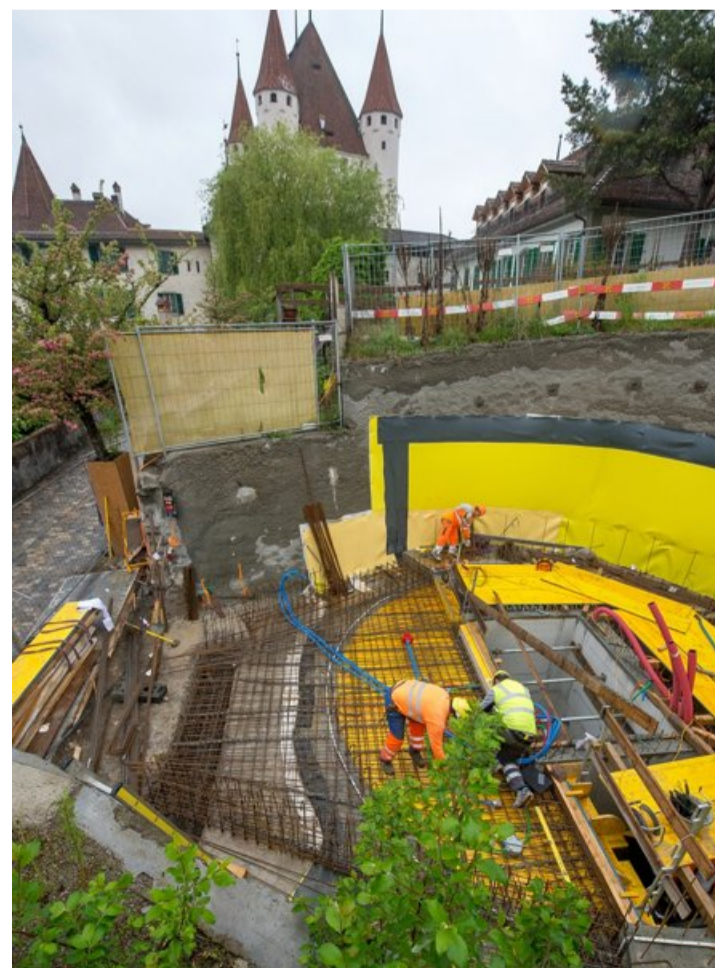
Die Arbeiten am Ein- und Ausstiegsbauwerk auf dem Schlossberg laufen auf Hochtouren. Ein Lift führt hier künftig direkt ins Parking.
